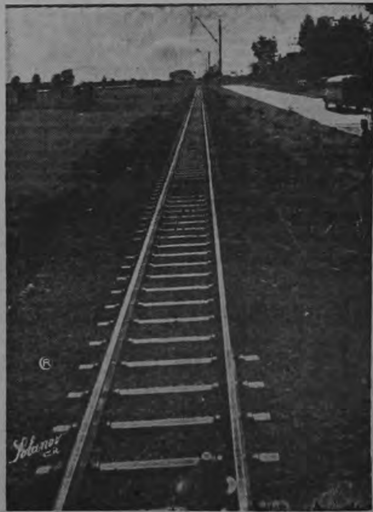
MODERNIZACION.— El Ferrocarril Eléctrico al Pacífico inició la suplantación de durmientes por otro sistema que no permite el ruido original que se nota en algunas secciones. Este trabajo permite ahogar el ruido que originalmente se nota. El proyecto de la Empresa es hacer el cambio total hasta Panlarcas. (FOTO SOLANOV).
